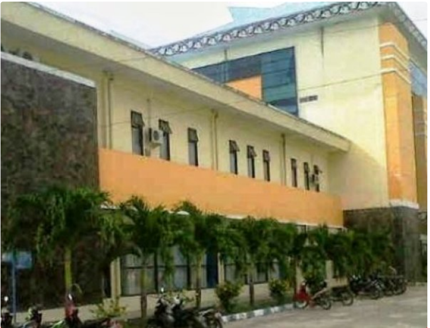
Keterangan Photo : RSUD Perdagangan
